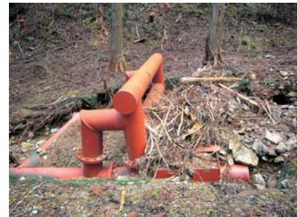
土砂等を抑止した簡易流木止め施設
