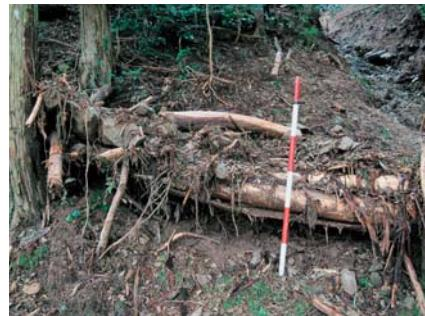
土砂流出を抑止した間伐木土留工
