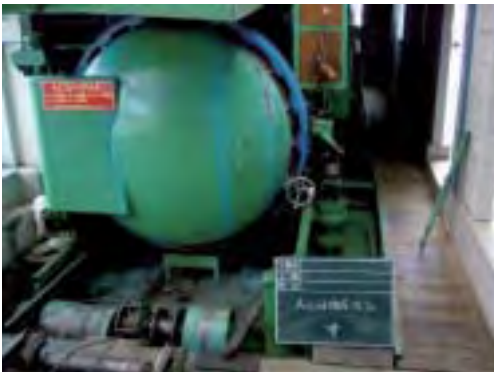
防腐加工 注入中（外注）
