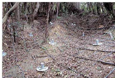
斜面安定工法(ロックボルト・ロープネット併用工法)は、立木の伐採を最小限に出来ることから景観を損なわず、既存工法に比べて安価に施工ができ、阪神・淡路大震災クラスの地震による山腹崩壊をも防止することができます。
