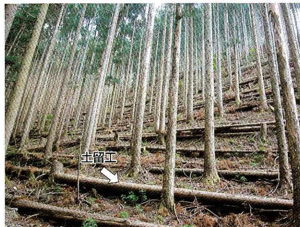
間伐木を利用した土砂流出を防ぐ土留工の設置
