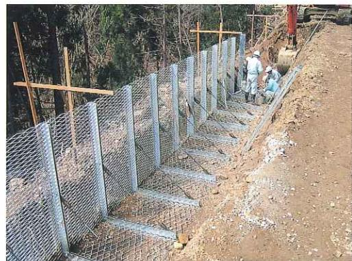
従来の擁壁より安価な鋼製の擁壁を使用しています。
