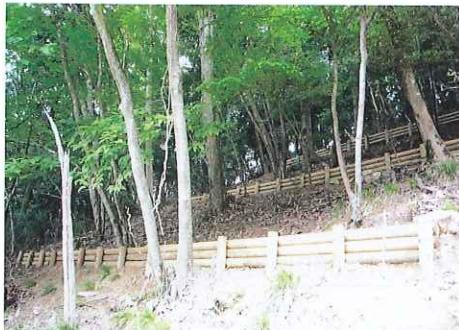
柵工(土砂の流出を留める簡易な防災施設)
