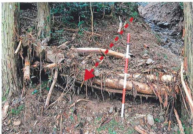
間伐木土留工が流出土砂を抑止（平成21年8月豪雨）
