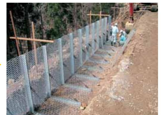
従来の擁壁より安価な鋼製の擁壁を使用しています。
